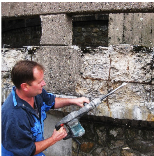
Obr. 7 Použití příklepového kladiva k odstranění nesoudržných povrchových vrstev degradovaného betonu
