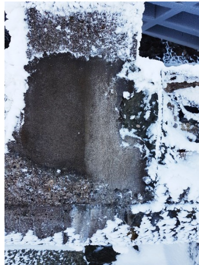
Obr. 14 Opravný beton po 6 měsících
