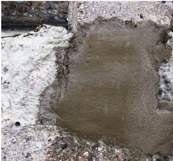
Obr. 13 opravný beton - detail
